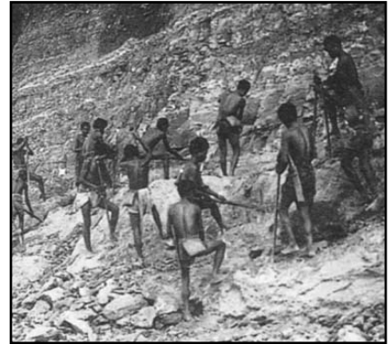
Herendiensten door Indonesiërs. Hier wordt er gewerkt aan nieuwe wegen.
